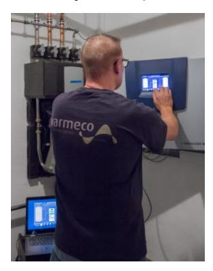
Vito Schiliro von varmeco bei der Inbetriebnahme am Regler VarCon380. Dieser Regler managt und optimiert alle Wärmeflüsse und lässt sich aus der Ferne via Internet einsehen und parametrieren.
