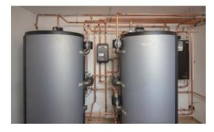
Im Zuge der Heizungssanierung wurden zwei neue Wärmespeicher, eine eXergiemaschine (rechts hinter den Speichern), eine neue Verrohrung sowie ein Vier-Kreis-Mischer installiert. Im Nebenraum befinden sich die Übergabestation für die Solaranlage, ein Frischwassererwärmer (Warmwasserbereiter) und der Systemregler der Heizungsanlage. (Bilder: varmeco)
