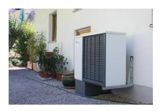
Die alte Ölheizung ist nun einem neuen System mit einer Luft-Wasser-Wärmepumpe (7 kW) als Hauptwärmequelle gewichen. Zusätzlich liefern vier Solarkollektoren thermische Energie in die Anlage. Da die Wärmepumpe für Niedertemperaturheizungen optimiert ist, findet ein energieeffizientes Nacherhitzen ("Boostern") durch eine eXergiemaschine compact statt.
