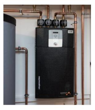
Die eXergiemaschine compact hebt mit geringem Energieeinsatz Wärme von etwa 35 bis 40 °C auf ein Temperaturniveau von über 60 °C, damit sowohl die Heizkreise mit konventionellen Radiatoren als auch die Warmwasserbereitung mit der passenden Vorlauftemperatur bedient werden.
