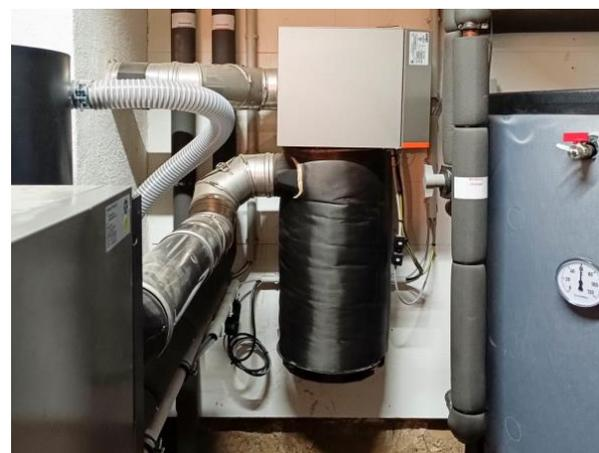
*An kalten Wintertagen unterstützt die Pelletheizung die Anlage (hier im Bild der Feinstaubfilter). Bei Außentemperaturen ab 5 °C können die Wärmepumpe und eXergiemaschine ausreichend Wärme bereitstellen.*
