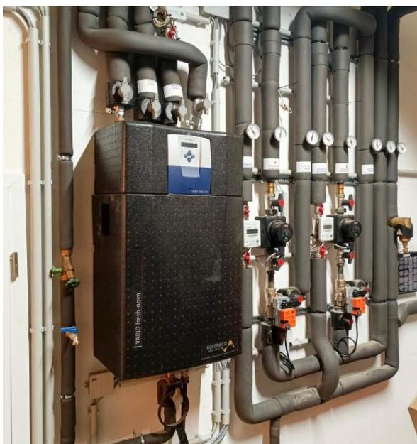
*Zur neuen Heizanlage gehört auch ein hydraulischer Durchlauferhitzer (schwarzes Gerät). Er nutzt die Wärme des Heizspeichers, um frisches Trinkwasser zu erhitzen. Dabei sind Heizkreis und Trinkwasser strikt getrennt.*
