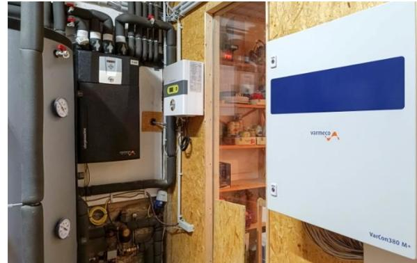
*Die eXergiemaschine (schwarzes Gerät links im Bild) hebt die von der Wärmepumpe gelieferte Temperatur auf zirka 65 °C an. Der Systemregler (rechts) dient der Überwachung aller Quellen und optimiert die Heizkreise.*
